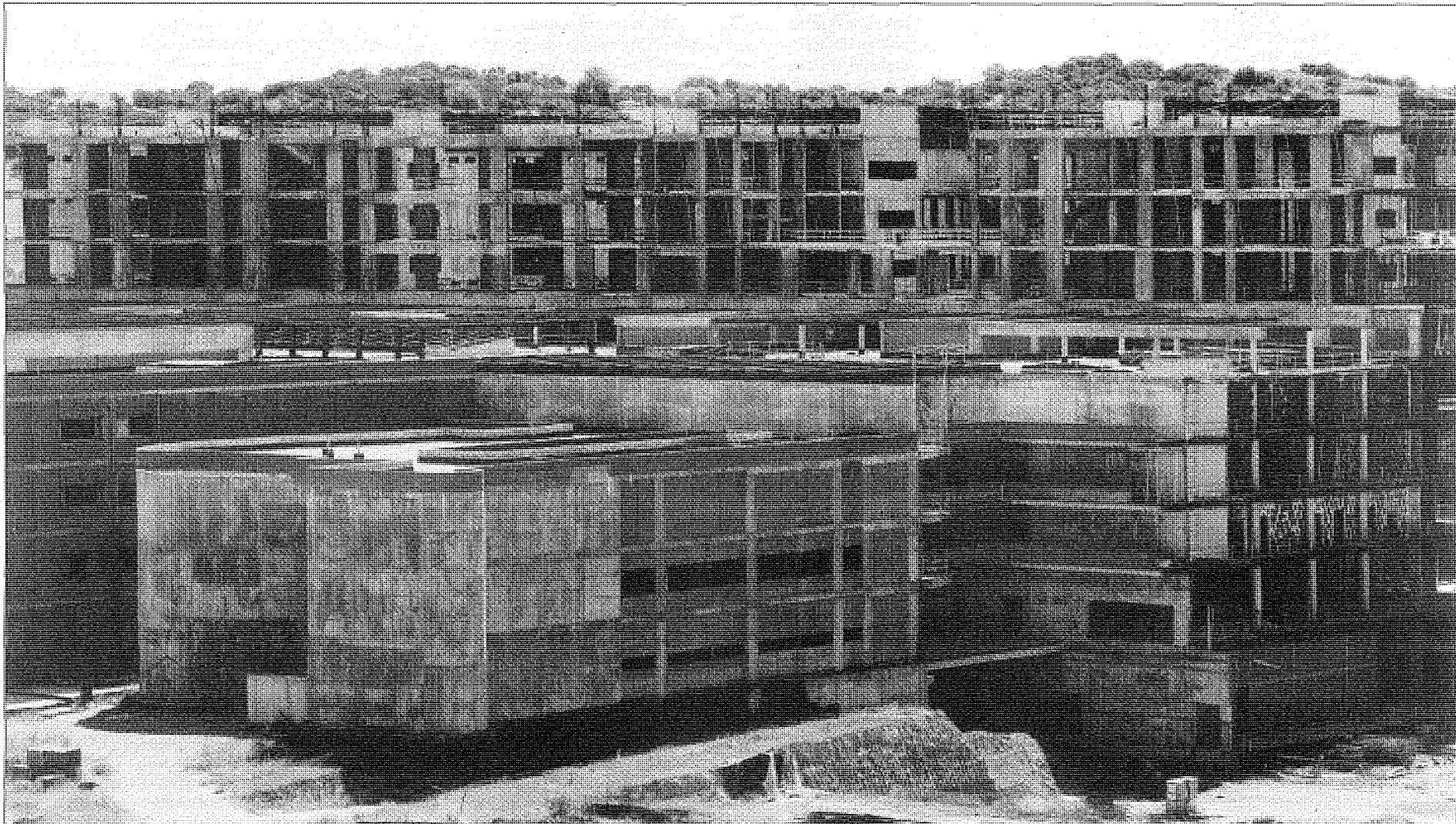
Si las demandas prosperan TASH advierte que hay precedentes en los que se ha ordenado la demolición de las construcciones y se puede condenar a la Administración a indemnizaciones millonarias. / Y. LANCHÁ
