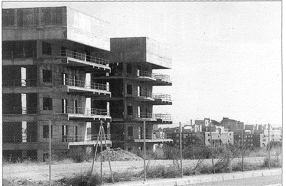
Estado actual del futuro hospital de Toledo. (Y. LANCHÁ)
